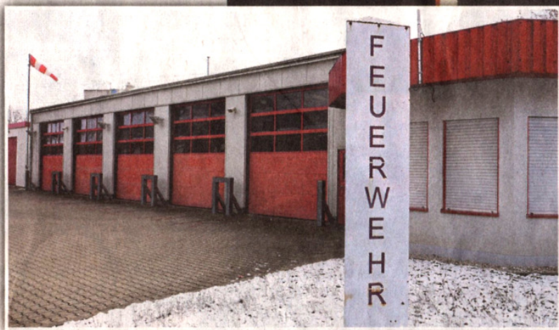
Das Feuerwehrgerätehaus in Crossen gehört zur Feuerwehr Crossen/Elstertal. Die Verbandswehr kümmert sich um Crossen, Hartmannsdorf, Walpernhain, Silbitz und Rauda.
